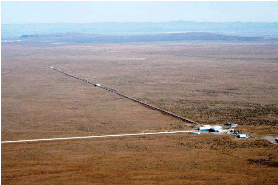
Vista aérea de las instalaciones de LIGO en Hanford. La fotografía muestra los dos brazos del interferómetro, de cuatro kilómetros de longitud. Crédito: Caltech/MIT/LIGO Laboratory.
